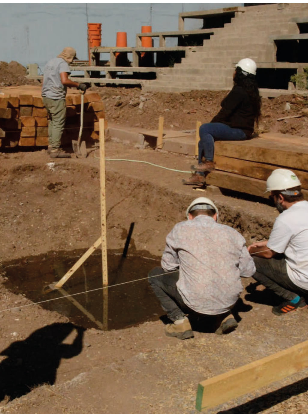
Figura 6: Esquema visual del procedimiento para estimar el volumen de agua almacenado.
